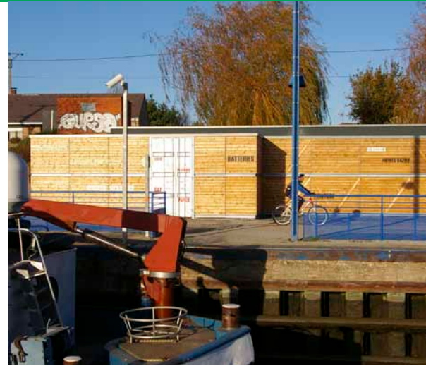
Déchetterie fluviale de l'écluse de Cuinchy
